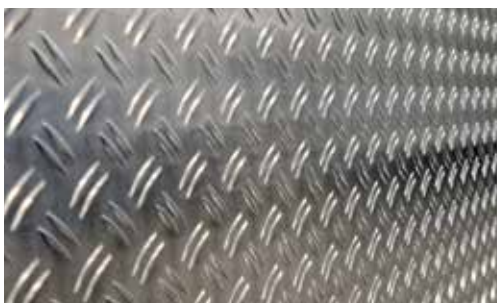
Plancher recouvert d'une tôle en aluminium striée
